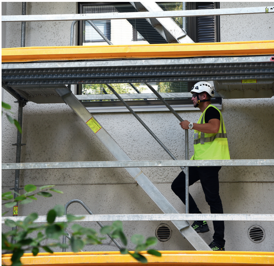
Kuva: Rakennusteollisuus RT:n kuvapankki
